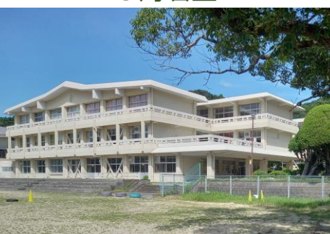
鶴南特別支援学校改修工事 3月完工
