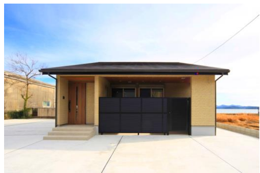
S 社様事務所新築工事 2月完成
