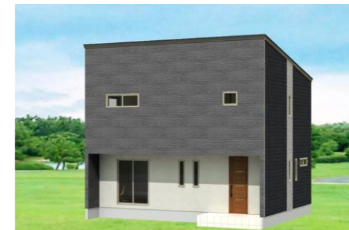
佐世保市N様邸 施工中
