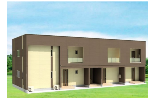
西海市西彼町 コーポYUZU 施工中
