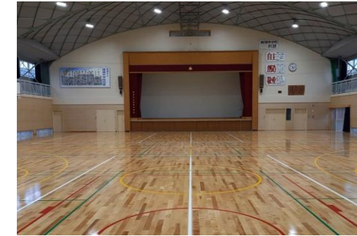
西彼中学校屋内運動場 2月完成
