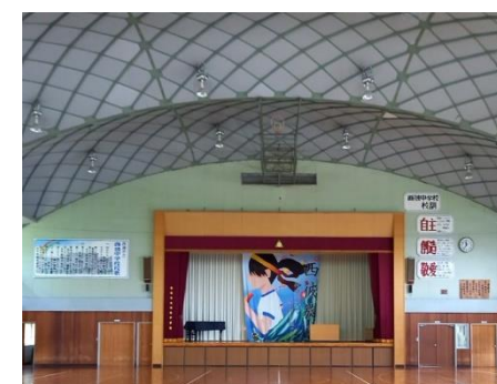
西彼中学校屋内運動場大規模改修工事 (建築内部工事)
