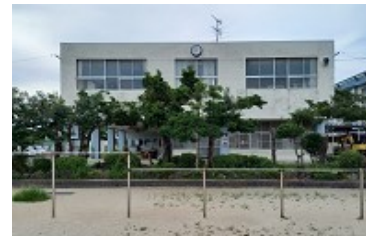
西海市立K小学校校舎大規模改修工事
