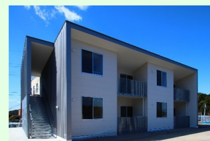
西海地区教職員住宅 新築工事 3月完成引渡し
