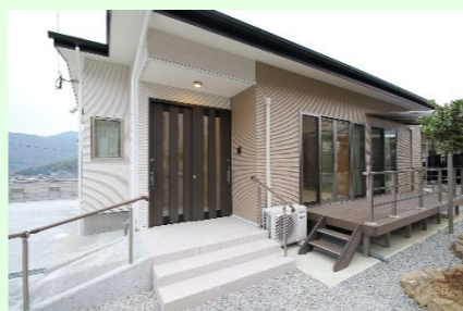
長崎市大浜町 K様邸 新築工事 3月完成引渡し
