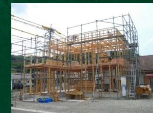
③構造材の建て方
